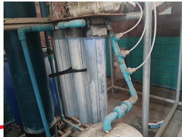
สวมด้ามถอด Filter box ที่จะเปลี่ยนให้แน่น หมุนทิศทวนเข็มนาฬิกา
