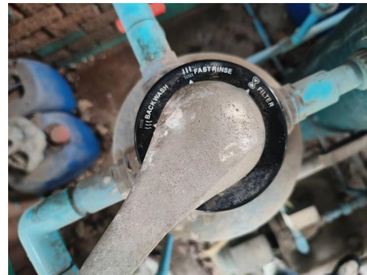
ตำแหน่ง Valve Multimedia filter
