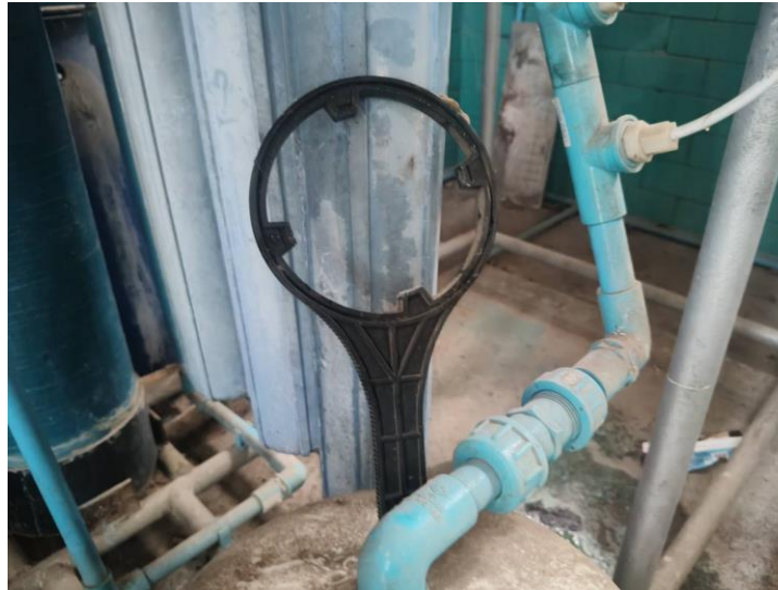
สวมด้ามถอด Filter box ที่จะเปลี่ยนให้แน่น หมุนทิศทวนเข็มนาฬิกา
