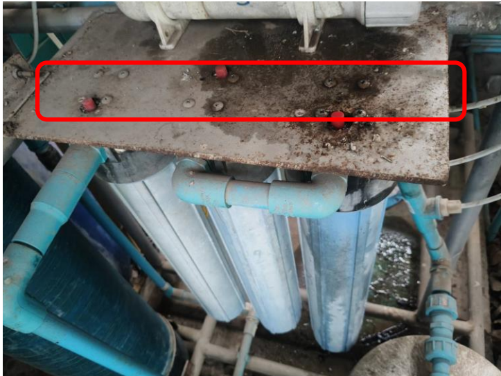
นำ Filter สวมใส่ให้ตรงแกนกลางของ Filter box
