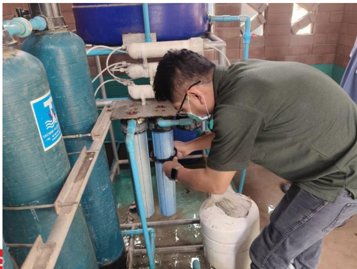
นำ Filter สวมใส่ให้ตรงแกนกลางของ Filter box
