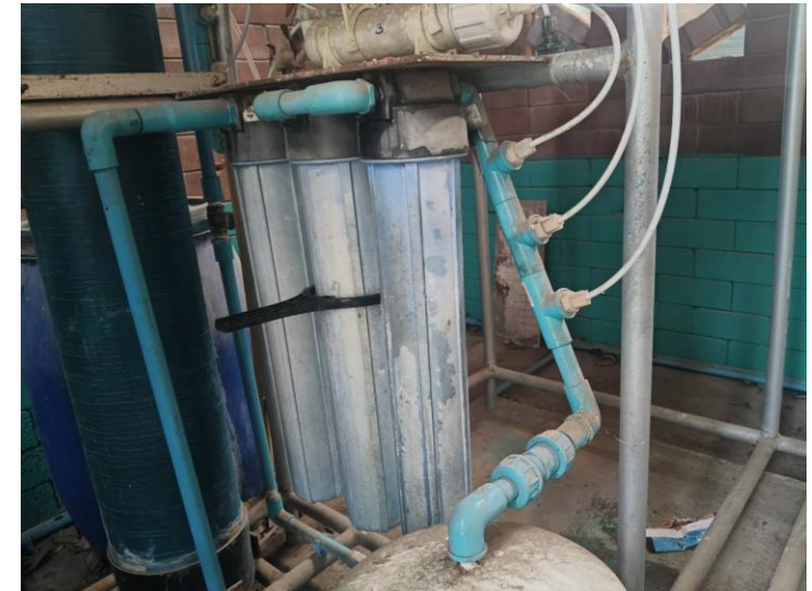
สวมด้ามถอด Filter box ที่จะเปลี่ยนให้แน่น หมุนทิศทวนเข็มนาฬิกา
